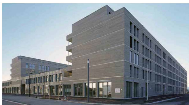
Bild 5 Null-Energie-Wohnsiedlung Eulachhof in Winterthur (Quelle: Allreal Generalunternehmung AG Zürich)
