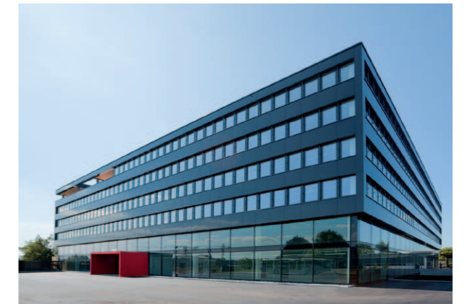
Reichle de Massari, hochwertige Kommunikationsnetze, Neubau
