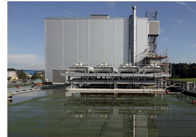
Pistor AG, Tiefkühlager
